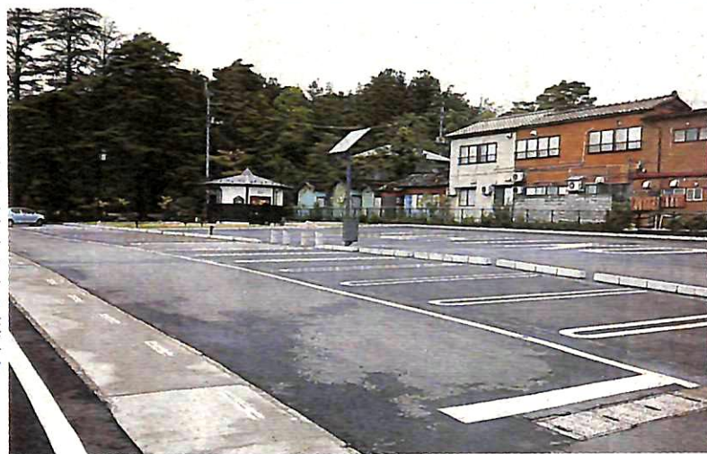
駅前水路側二十一台分の駐車場
