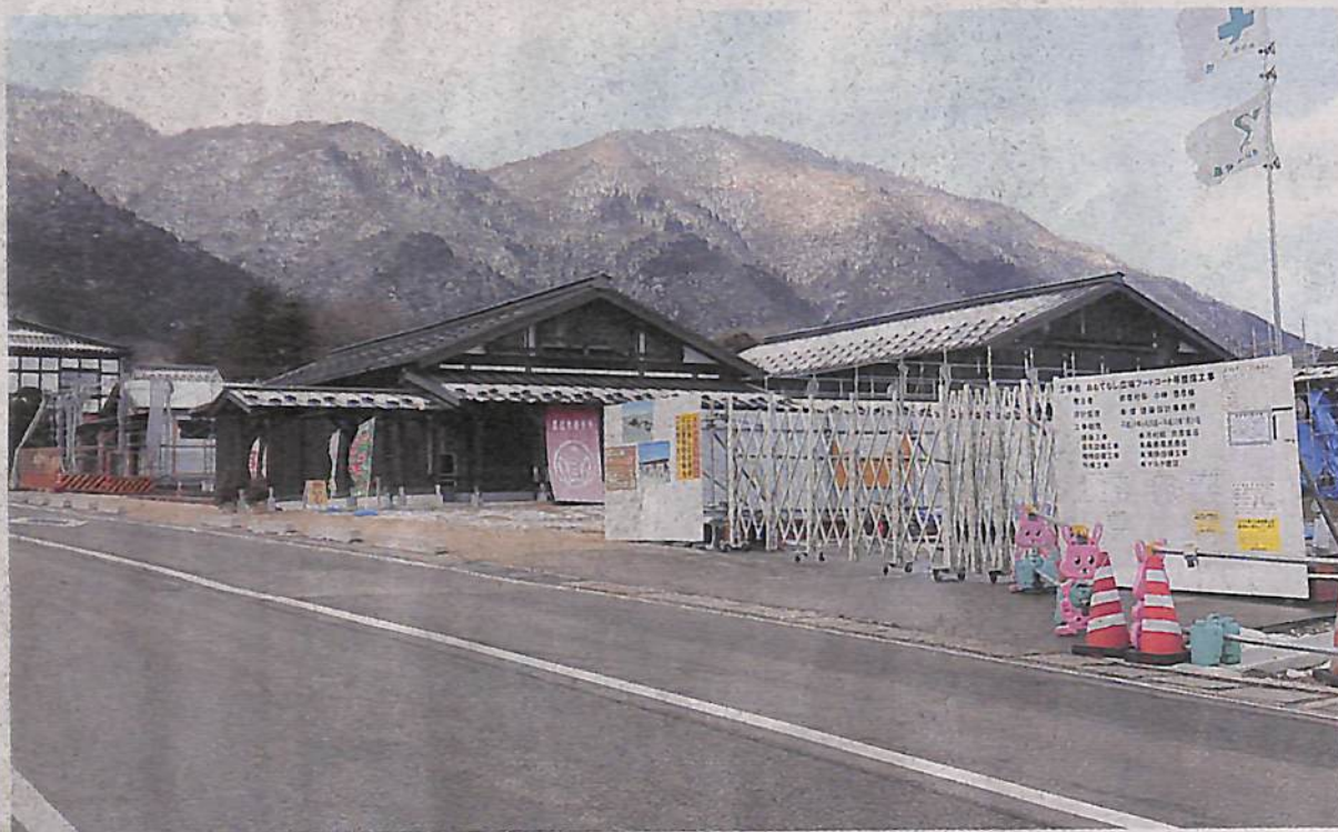
3月下旬のグランドオープンに向けて工事が進むおもてなし広場
